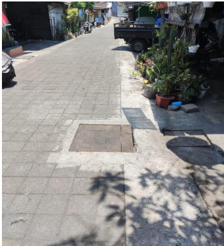
Main hole yang digunakan untuk kontrol/perawatan saluran utama
