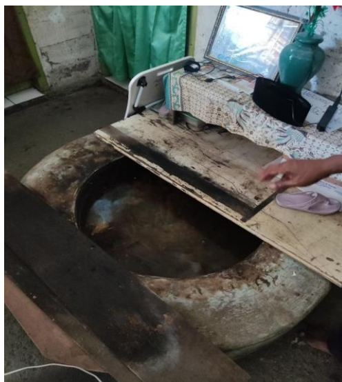
Bio digester yang digunakan untuk mengubah senyawa organik menjadi biogas
